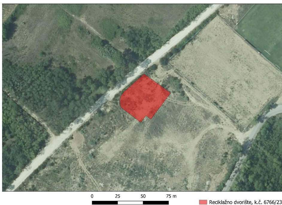
Slika 21. Izgradnja i opremanje reciklažnog dvorišta na kat.čest.br.6766/23
